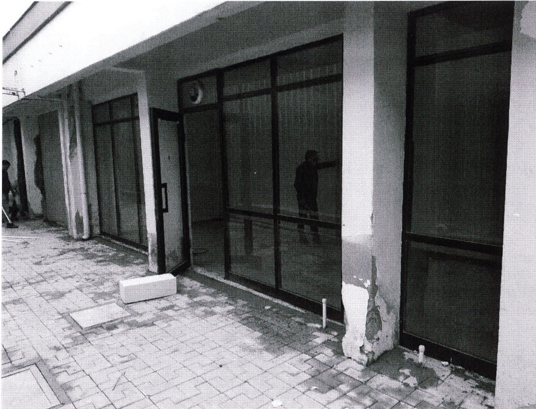
Depo alanı olarak kullanılacak ve tadilatı yapılacak bölüm
